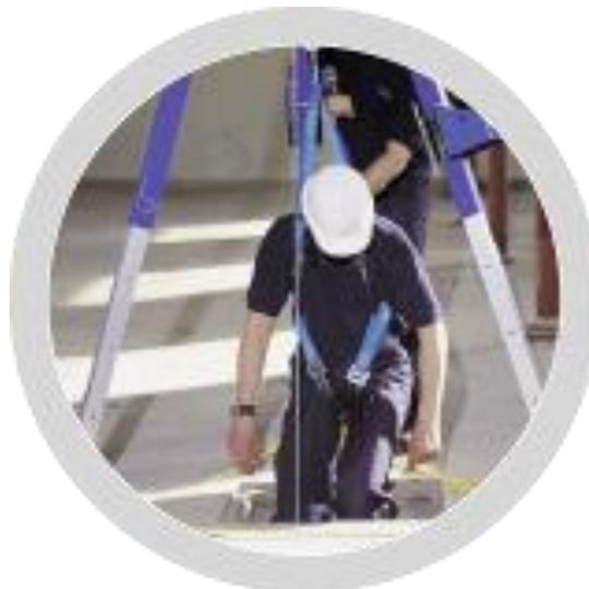
Figura 17 Ancoraggio a tripode per accesso orizzontale
