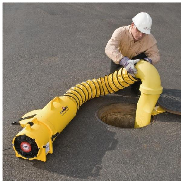
Aspirazione di aria (pressione negativa): secondo il piano di ventilazione dell'aria si vanno a predisporre di intervalli di bonifica dello spazio confinato mediante l'uso di aspiratori (esempio visto in fig.3).
